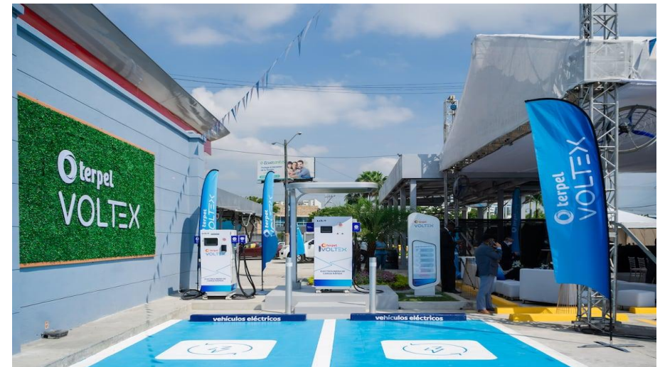
Fotografía 10. Modelo de electrolinera instalada.
